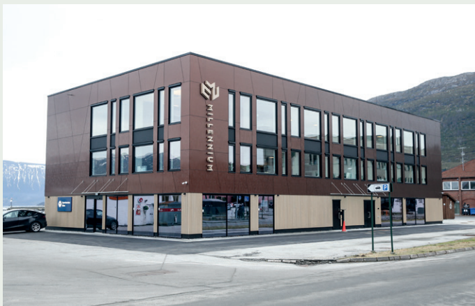
Millennium Cowork sett fra nordvest. Sparebanken Møre har etablert seg med kontor på gateplan nærmest, mens Millennium Kafé holder til på gateplan til høyre.
